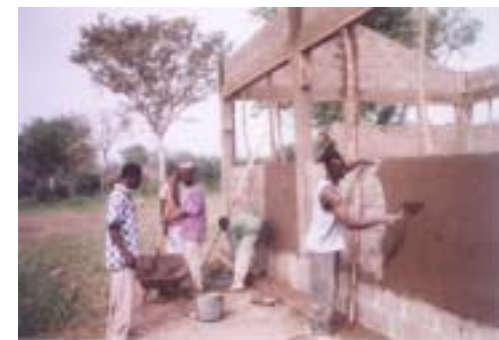
Construction de la première salle de classe en dur du hameau
